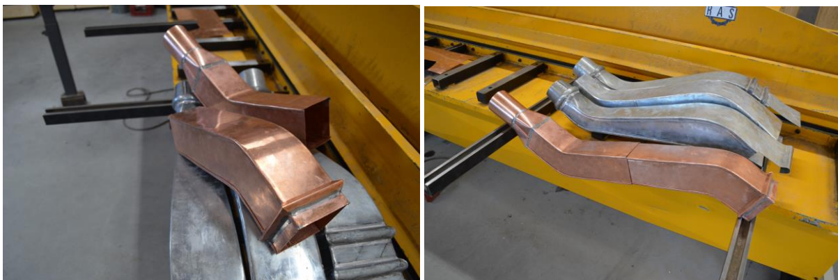
Bildene på foregående side og her viser gangen i arbeidet med nedløpet i kobber. Fra falsing, innvendig loddning, ornamentering, deling av nedløpet mellom vinklene og forskjellen på de fire nedløpene vi laget.
