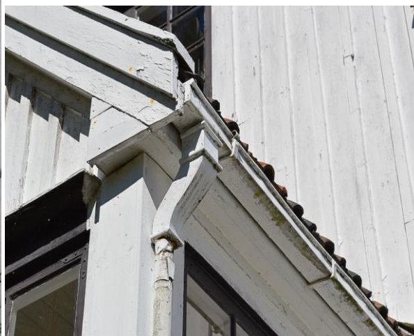
Renne og nedløp i Drøbak (t.v.) etter en artikkel og bilde av Røhrne, og renne og nedløp fra hus på Buøya ved Arendal (t.h.).
