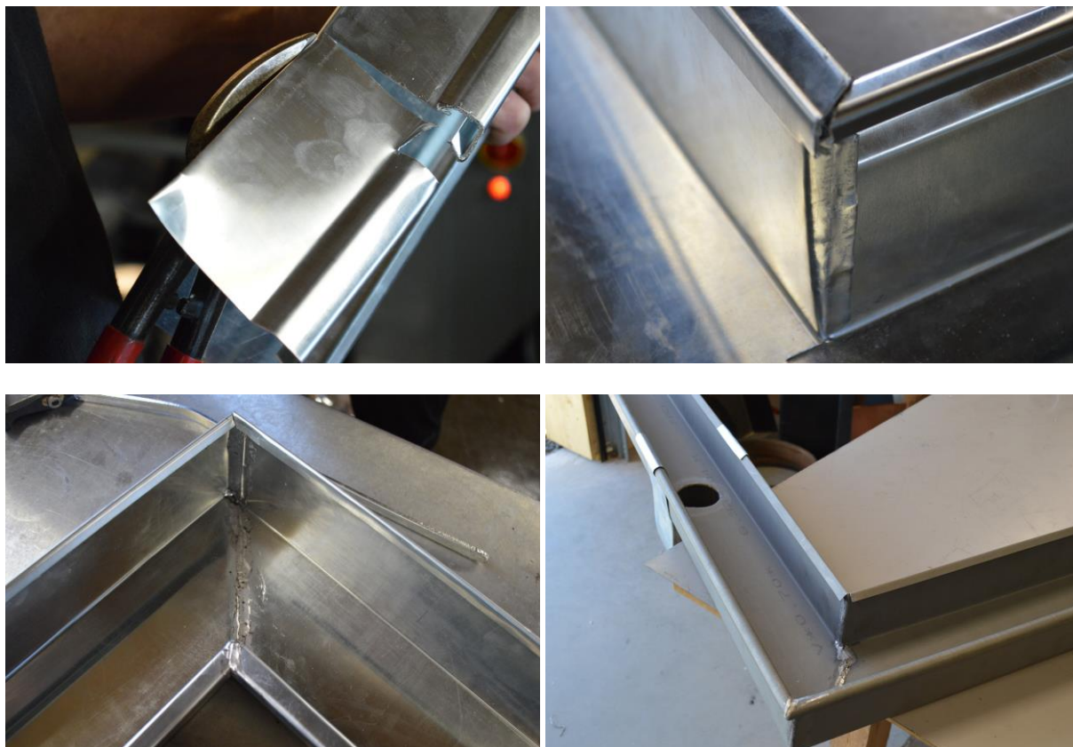
Arbeidsgangen fra rett lengde lagd i vulstmaskina, til å knekke til 90 gr., brette og lodde.
